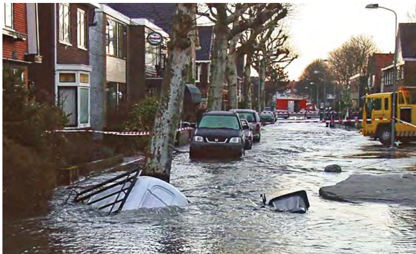
شکل ۲. (چپ) اتلاف حجم آب. اتومبیلی در گودال افتاده که بر اثر نیروی آب ایجاد شده است.
